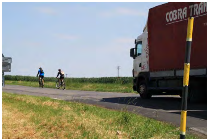
asfaltový povrch silnice II. třídy mimo zástavbu
