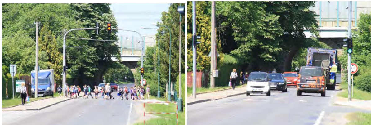
Světelná brána s přechodem pro chodce ve Světicích (pokud jede vozidlo rychleji, než je dovoleno, dostane signál stůj, přestože žádný chodec nezmáchl výzvu pro chodecké volno)
