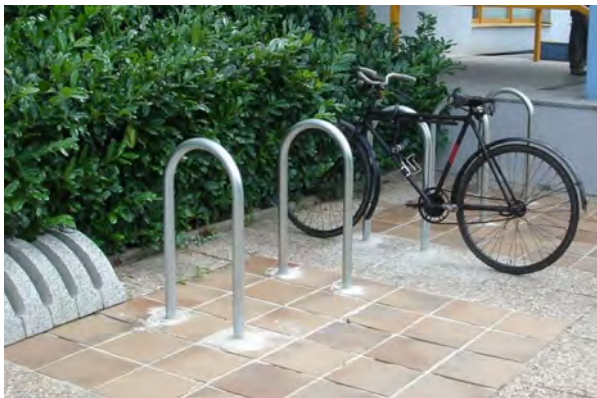
vlevo na snímku jsou patrné původní nevhodné stojany (betonové bloky), vpravo již 5 nových bezpečných stojanů s kapacitou pro 10 jízdních kol (Praha Letňany)
