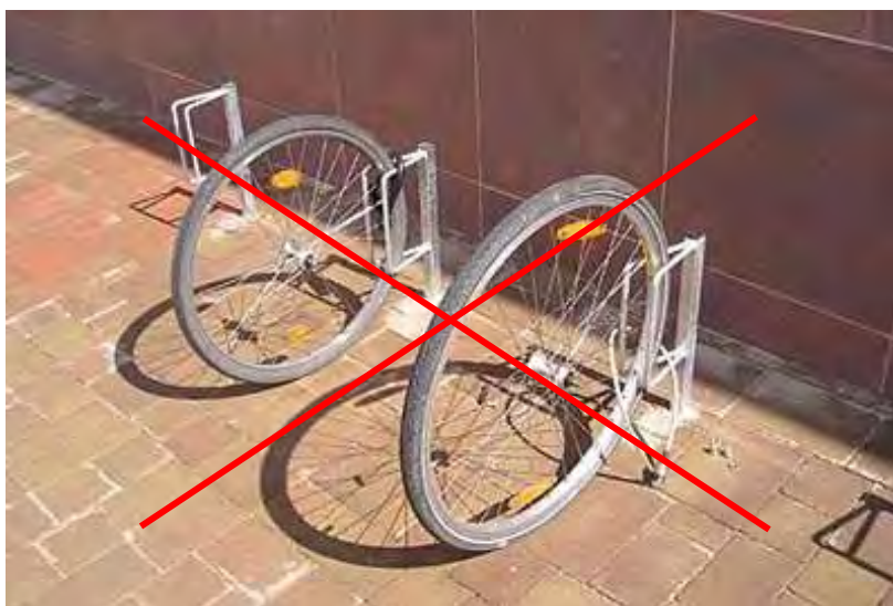
Příklad špatného parkování pro jízdní kola (Praha, stanice metra Ládví),
