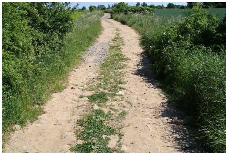
Provoz těžké techniky na cestě s postupně naváženými velkými kameny
