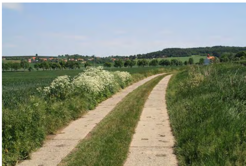
Polní panelová cesta určená pro provoz těžké techniky
