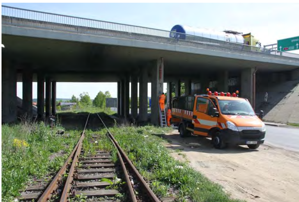
Málo využívaná žel. vlečka může v budoucnu plnit funkci „drážní stezky“
