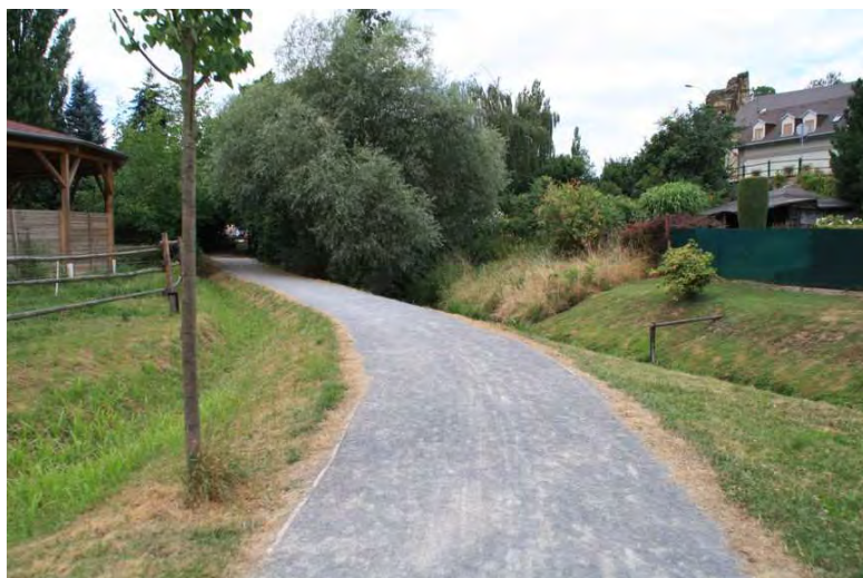
Parkové cesty / úpravy zpevněných ploch – mlat, štěrk
