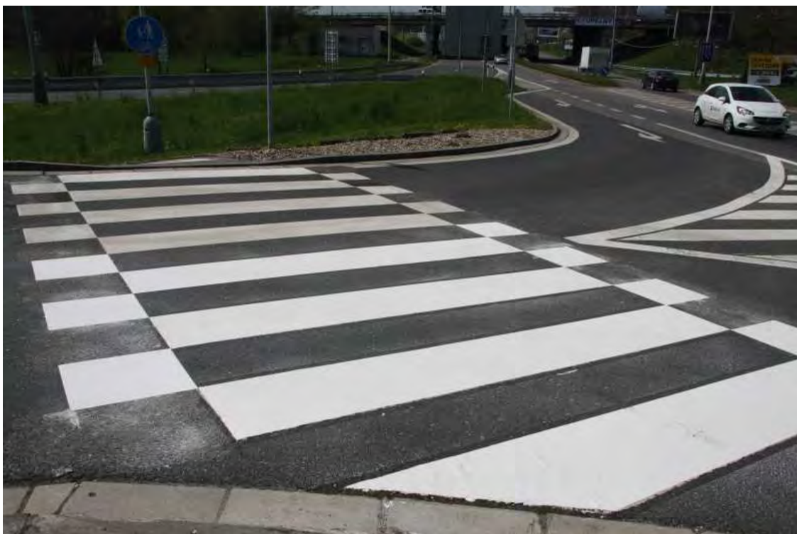
Vzorové řešení sdruženého přechodu pro chodce a přejezdu pro cyklisty, které propojuje stezky pro chodce a cyklisty se společným provozem.
