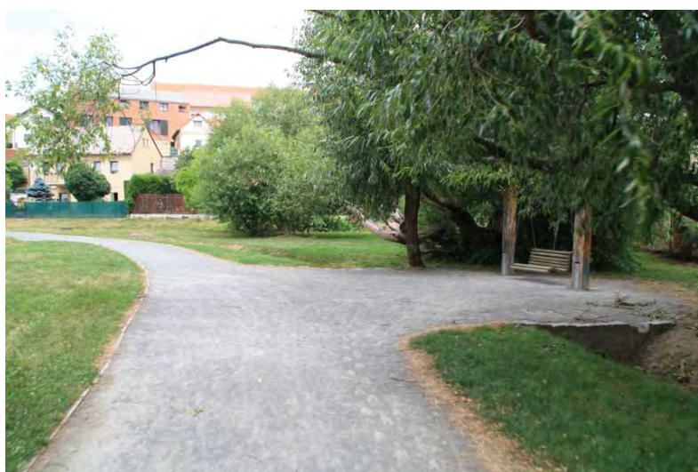
Parkové cesty / úpravy zpevněných ploch – mlat, štěrk
